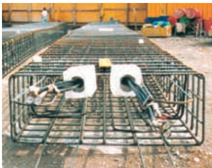
Mittels Wärmetauschersystem aufgerüsteter Armierungskorb einer Energieschlitzwand.
