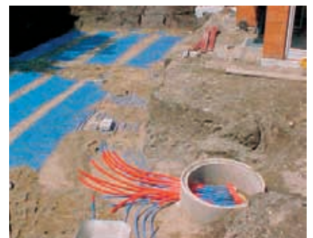
Einbau eines Kapillarrohrmatten-Erdwärmekollektors bei einem Neubauprojekt.
