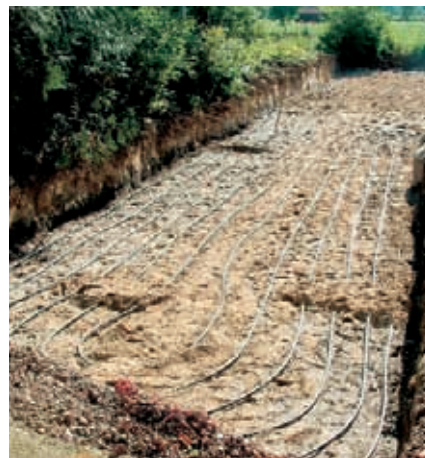
Einbau eines Kapillarrohrmatten-Erdwärmekollektors bei einem Neubauprojekt.
