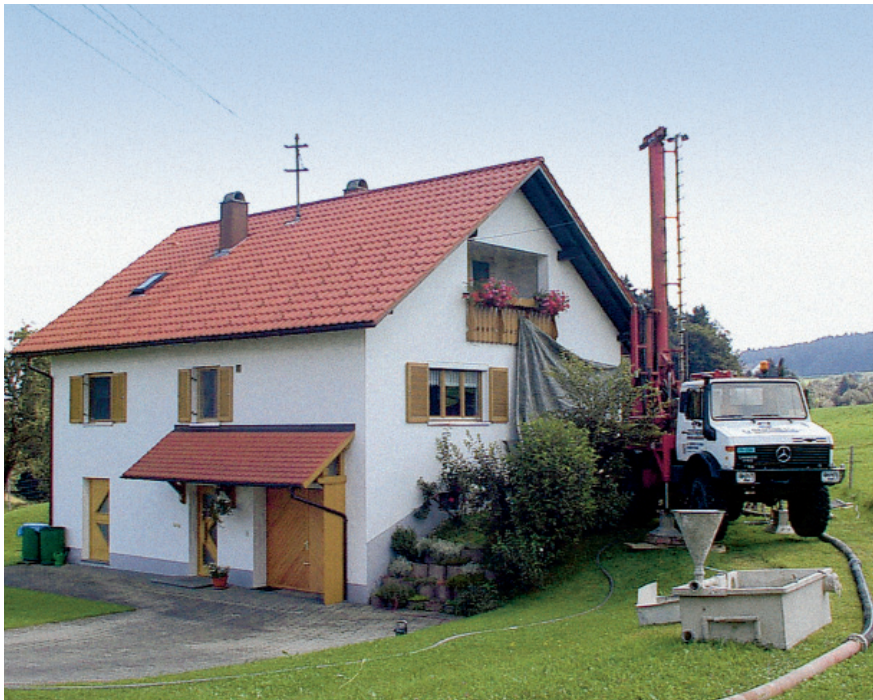
Bohrarbeiten für eine Erdwärmesonde an einem Einfamilienhaus.
