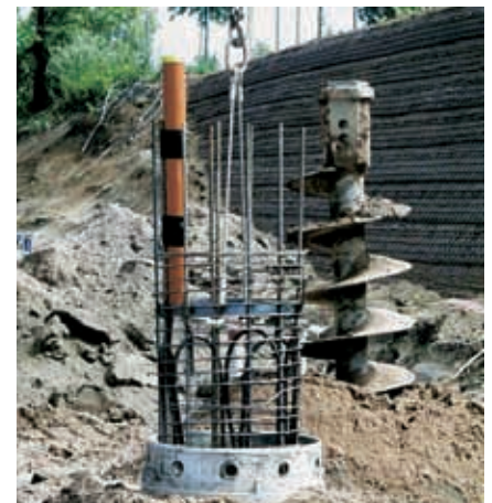
Einbau des Energiepfahl-Armierungskorbes in die mittels Mantelrohr stabilisierte Schneckenbohrung.
