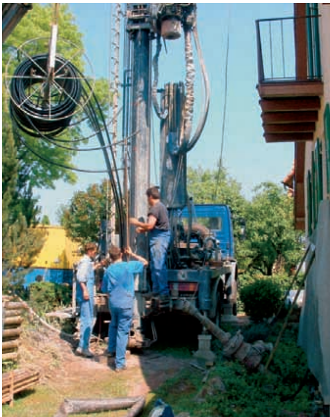
Bohrarbeiten für eine Erdwärmesonde an einem Einfamilienhaus.
