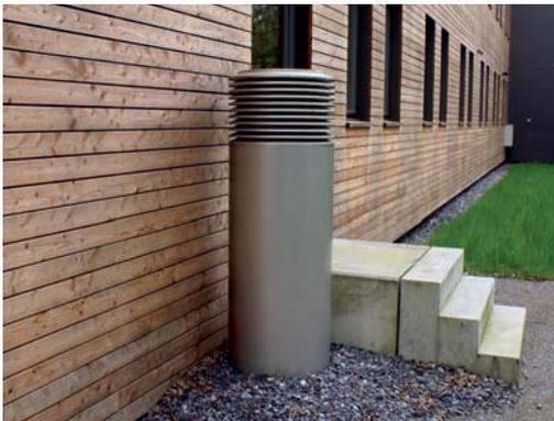
*Ansaugöffnung für kontrollierte Wohnraumlüftung (mindestens 80 cm über Boden)*
