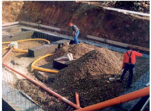
Einbau einer Radondrainage in Kies beziehungsweise Schotter
